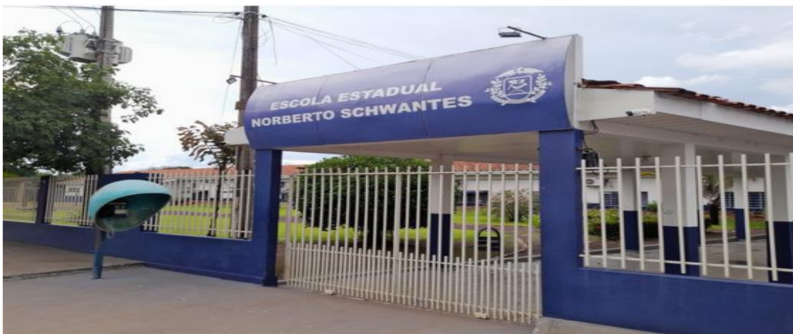
Figura 4 - Fachada da Escola Estadual “Norberto Schwantes”
